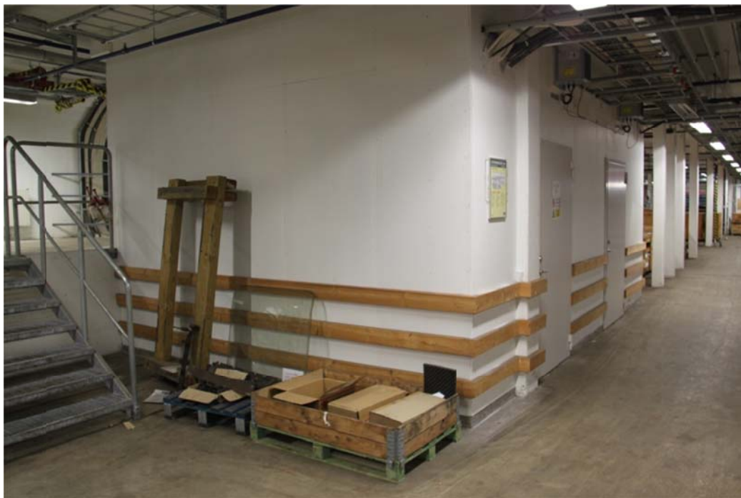
Bild 6: Ställverksrum för 750 V samt UPS-rum under spår 21.
